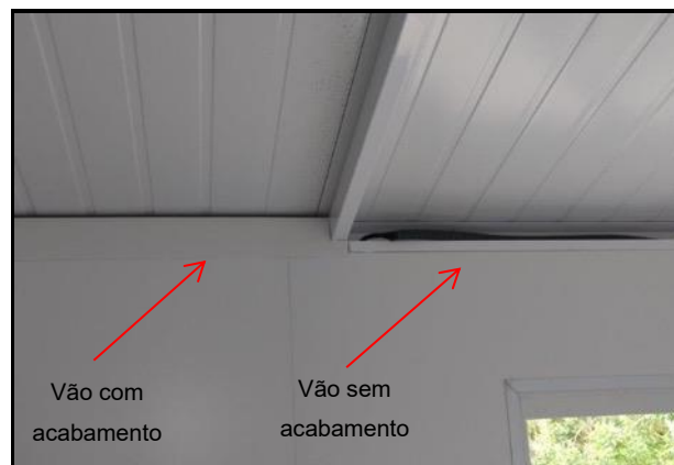
Figura 59 – Vão para tubulação elétrica.
