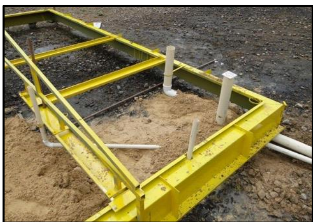
Figura 72 – Posicionamento das tubulações hidrossanitárias.
