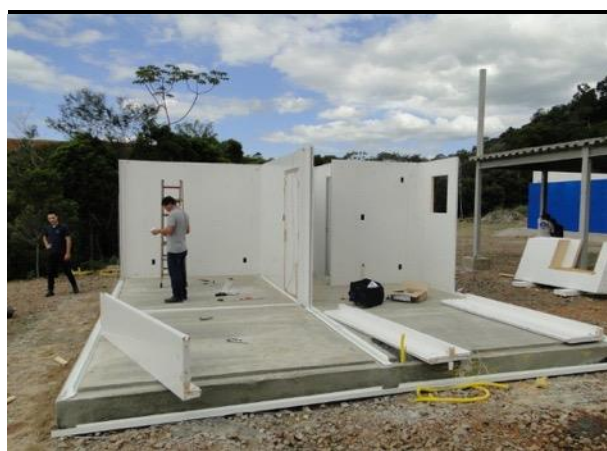
Figura 78- Início da montagem dos painéis de parede.
