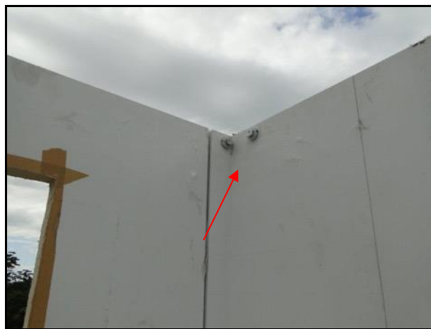
Figura 80- Pinos para bloqueio (painel “L”).
