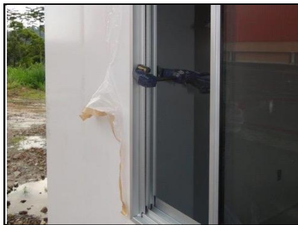
Figura 49 – Encaixe do quadro da janela.
