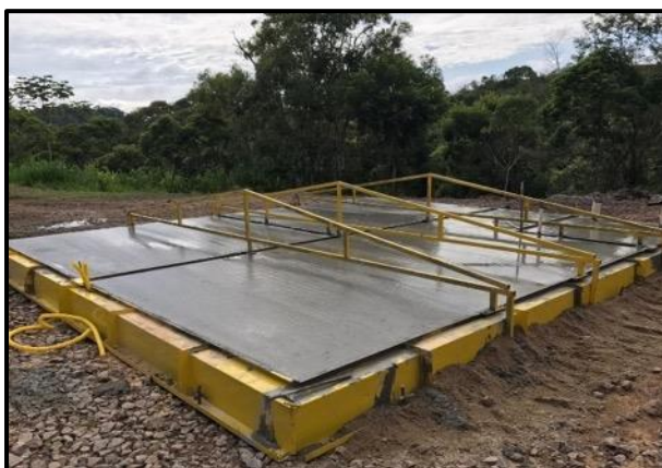
Figura 75 – Radier após concretagem e superfície acabada.
