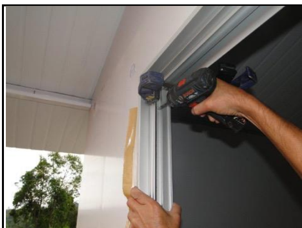
Figura 50 – Fixação da janela com parafuso.
