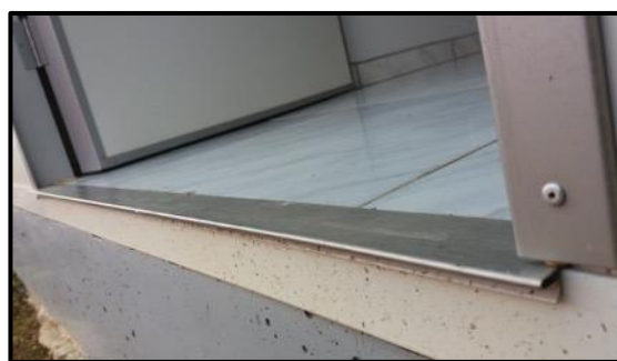
Figura 26– Soleira de aço inox, protegendo a calha “U” em PVC (área da porta)
