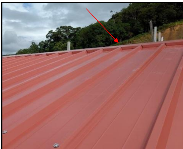
Figura 83 – Instalação da cumeeira.
