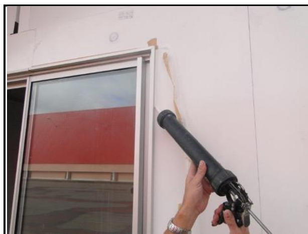
Figura 51 – Vedação com selante das extremidades da janela.
