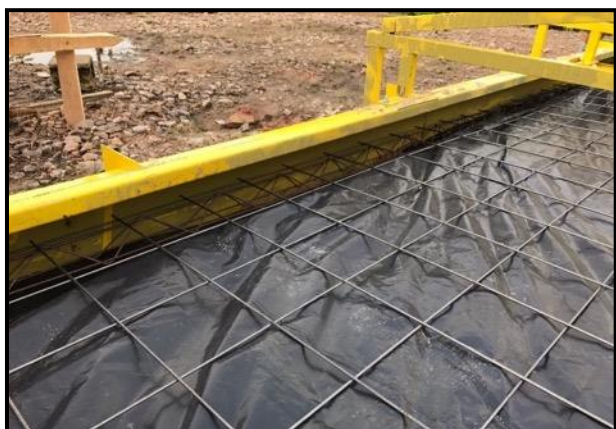
Figura 74 – Armadura do radier (treliça e tela soldada)
