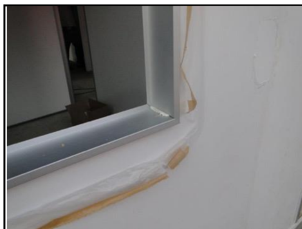
Figura 47 – Encaixe dos contramarcos.
