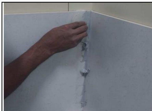
Figura 13- Rejunte epóxi entre as cerâmicas.
